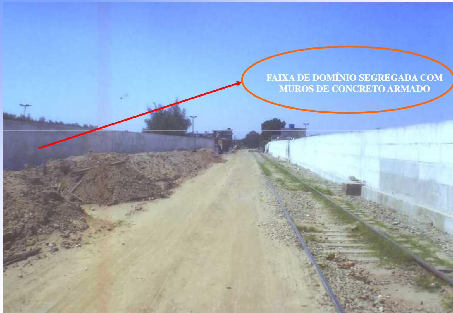
Faixa de Domínio Totalmente Liberada e com Muros de Segregação de Concreto Armado Construído
