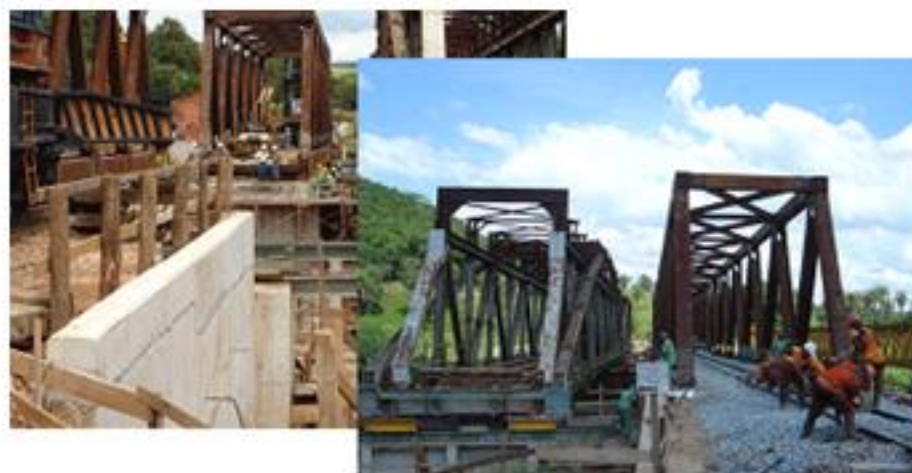
Substituição da ponte Paraopeba
