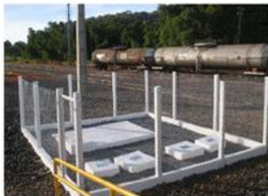
Construção de fossa séptica
