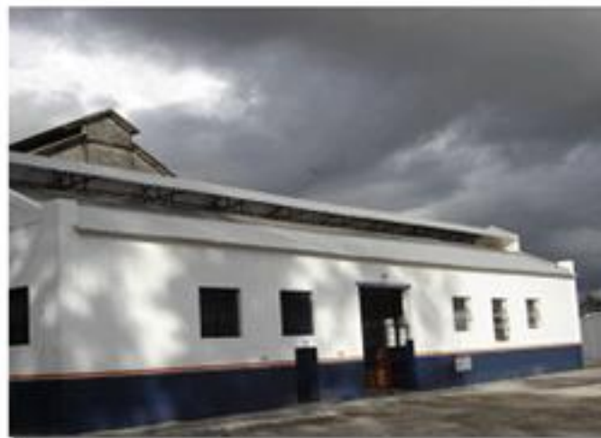
Nova edificação em Alagoinhas
